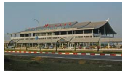
(写真:ラオス・ビエンチャン空港ターミナル)
